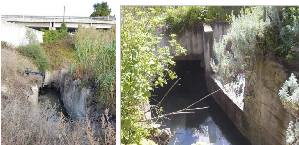
Figura 12 – Manufatto di confluenza tra il rio Calamasciu (a destra) e i canali di raccolta delle acque meteoriche dell'area di Predda Niedda (settore oggetto del primo intervento)
